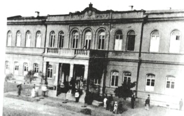
Bakı şəhərində Nikolayevski küçəsində bina (hal-hazırda 132- 134 saylı tam orta məktəbin binası) (1920-ci il)
